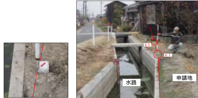
K1 コンクリート杭
