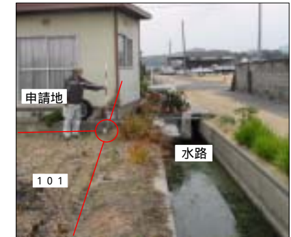
K3 コンクリート杭
